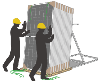
8. 剪断剩余打包带，使组件靠在靠架上
